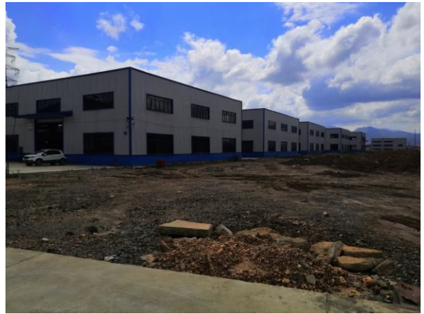
项目生产车间
