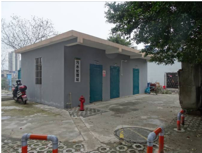
项目现有污水处理站
