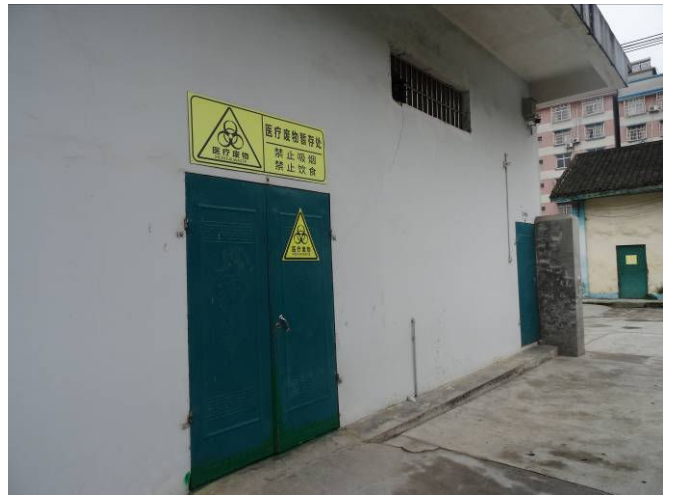
项目现有医疗废物暂存间
