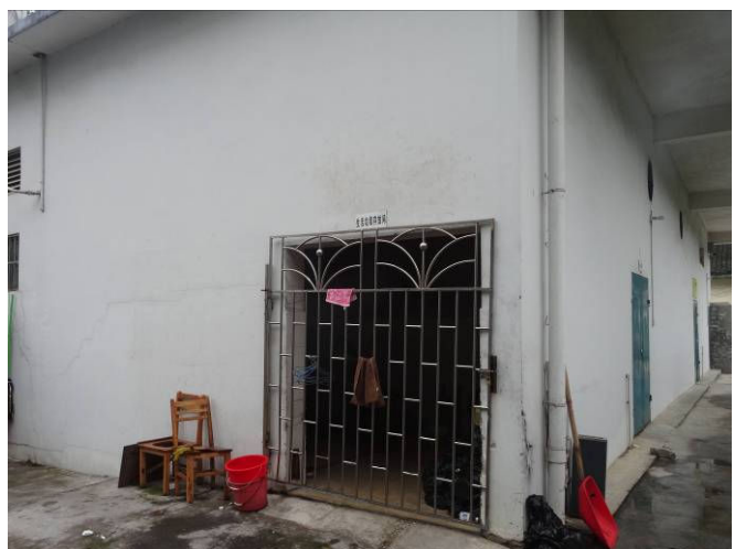
项目现有生活垃圾存放间
