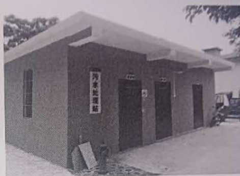
医院污水处理站
