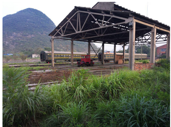
东面铁路及站场
