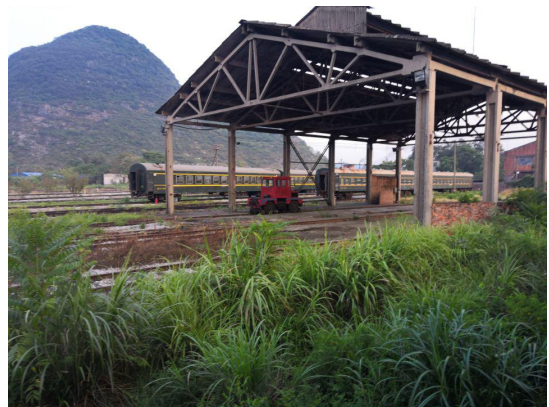
东面铁路及站场
