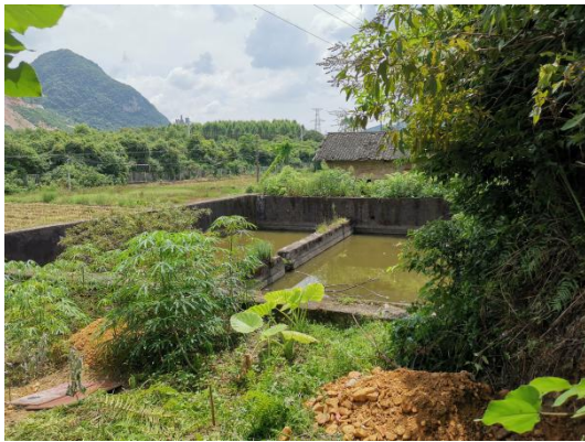
项目西北面稻田及原厂废弃雨水池
