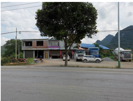
北面 209 国道及道路对面木材厂
