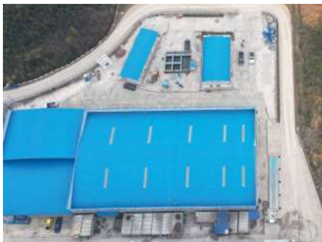
项目厂区现状
