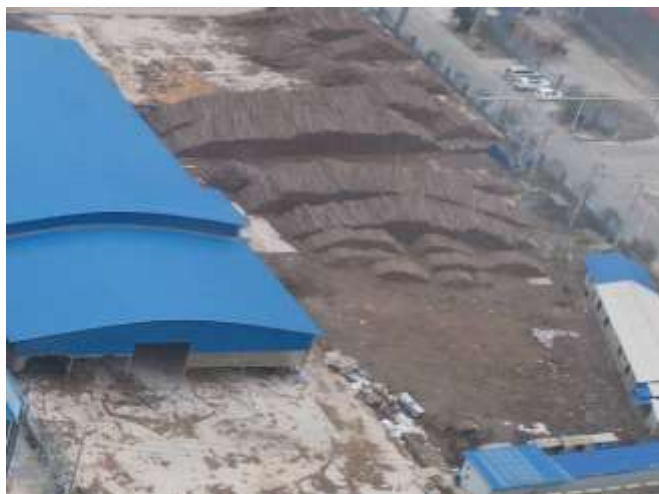
项目东面融安县木林森生物能源有限公司
