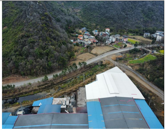
项目东面 209 国道及隘底屯居民点
