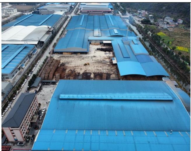
项目北面延兴木业等企业
