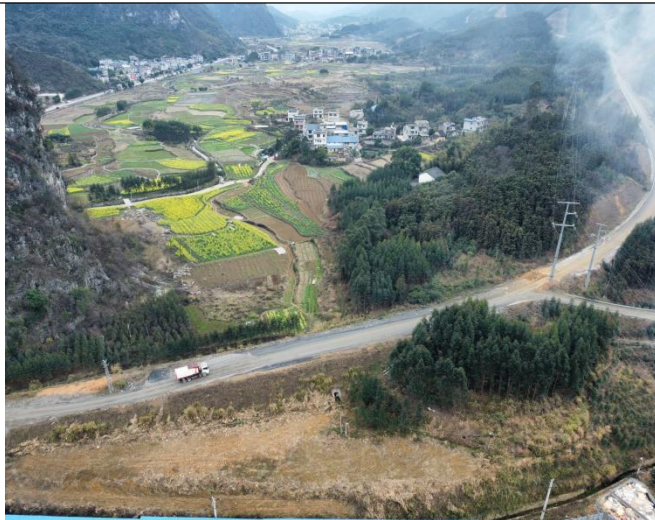
项目南面道路及独庆屯居民点
