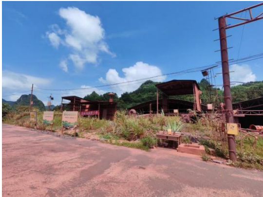
项目西侧破碎站原破碎线
