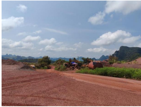
项目南侧破碎站及矿区道路
