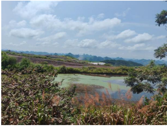
项目东侧雨水收集沉淀池
