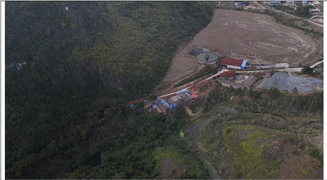
项目北面现状
