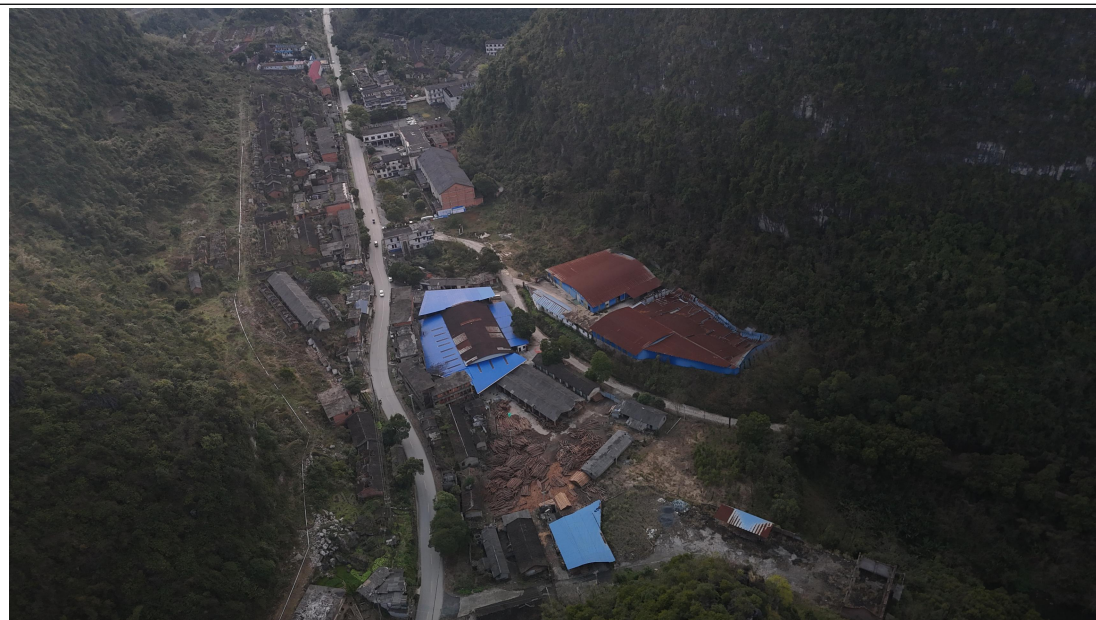
项目西面现状
