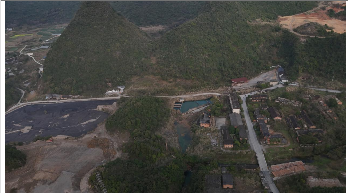
项目东面现状
