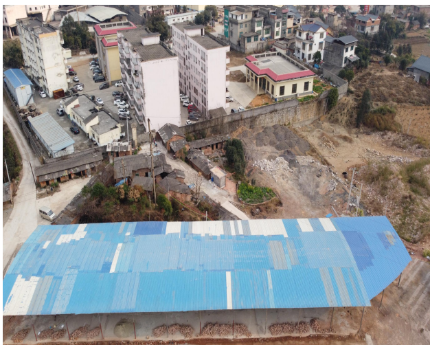
东面大林水泥砖厂及九龙屯
