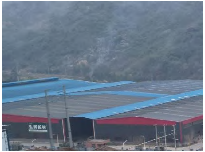
项目东面工业厂房
