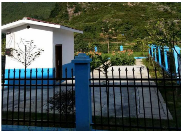
浮石镇泉头村仁村屯污水处理设施项目图
