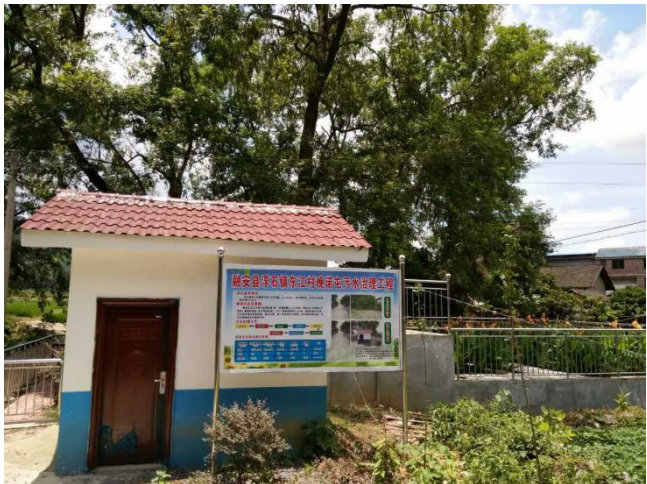
浮石镇东江村晚诺屯生活污水处理项目图
