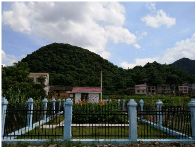
浮石镇东江村西里屯生活污水处理项目图
