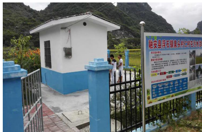
浮石镇泉头村仁村屯农整项目
